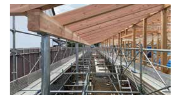
▲道の駅 石鳥谷 施工
